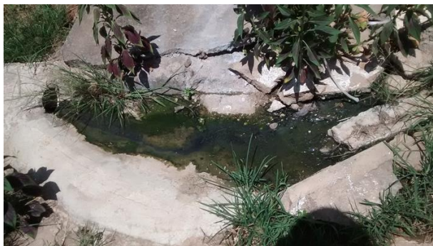
Figura 2. Lançamento de esgoto doméstico à céu aberto próximo a uma residência. (Fonte: os autores, 2016).
