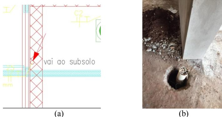
Figura 1. Incompatibilidade na prumada elétrica (a) e solução executiva (b).
