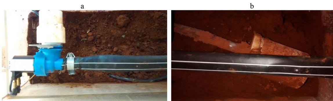
Figura 2. Partes do protótipo do sistema de acionamento automático de baixo custo “Pinga” instalado no setor de Horticultura da Universidade de Rio Verde; ligação da água e válvula solenoide (a) e vela desenterrado e a mangueira de gotejamento (b).
