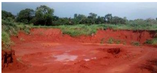
Figura 2. Vala aberta para receber os resíduos do município de Bom Jardim de Goiás
