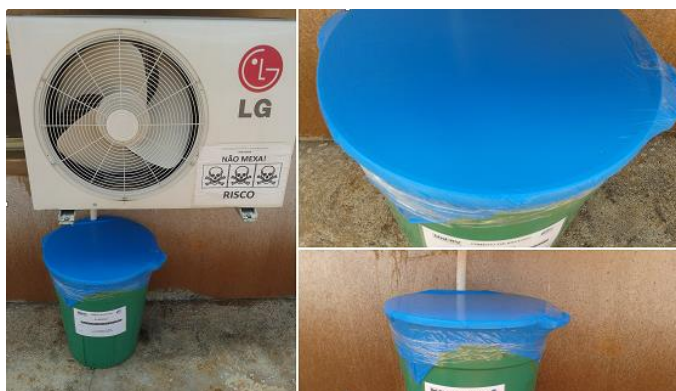
Figura 1 - Instalação do coletor na saída do dreno.
