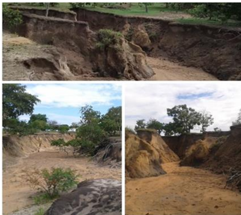
Figura 3. Erosões Encontradas na Bacia do Córrego das Galinhas (Foto Tirada pela 2ª Turma de Engenharia Ambiental, 2014).
